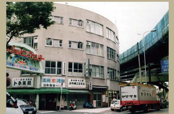
▲1958年竣工の大阪府住宅協会 桜川住宅
